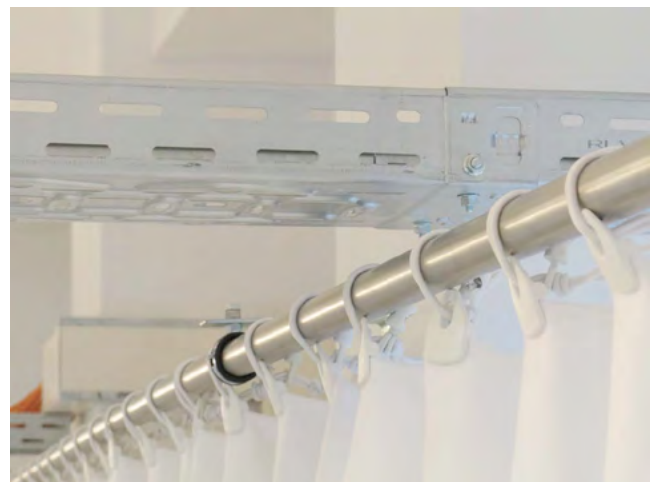
Akustikvorhänge aus weißem Bühnenmolton absorbieren den Schall. (Foto: Fabian Scholz | Bild Wissen Gestaltung 2015)
