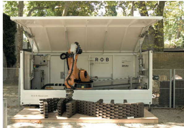
Abb. 5: Wandaufbau durch einen Roboter für die Installation Structural Oscillations in Venedig, 2008.
